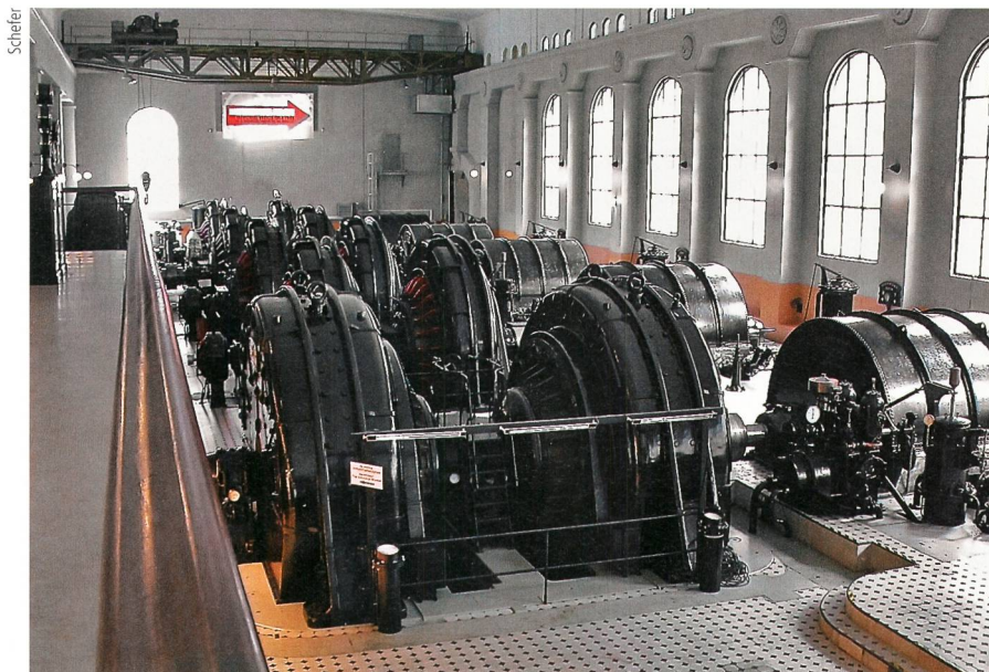
Bild 4 Maschinensaal Ausrüstungsstand ähnlich zur Situation 1929, KW Vemork (2012).
