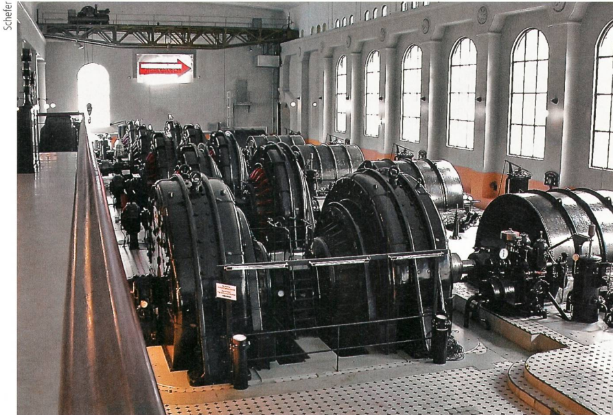
Bild 4 Maschinensaal Ausrüstungsstand ähnlich zur Situation 1929, KW Vemork (2012).
