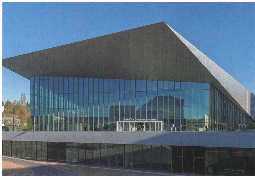
Le SwissTech Convention Center est le bâtiment idéal pour accueillir le Congrès national photovoltaïque.
