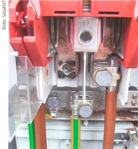
**Bild 6** Mangelhafte Verschraubung.
