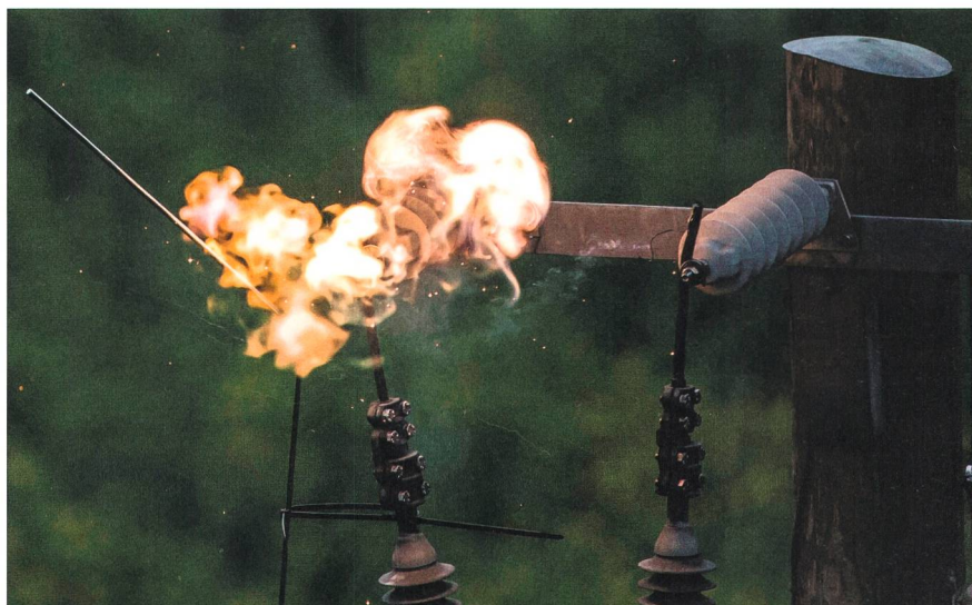
Bild 1 Im Probetrieb wurden Lichtbögen provoziert.
