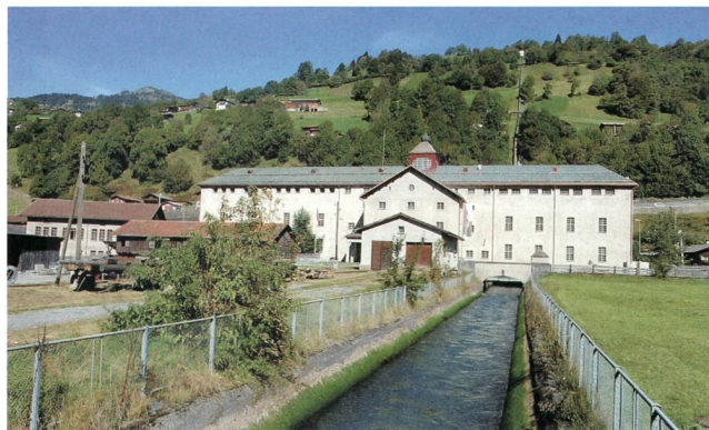
Bild 3 Das im Kraftwerk Küblis (Bild) turbinierete Wasser wird nicht mehr in den Talfluss Landquart geleitet, sondern direkt in einem über 16 Kilometer langen Druckstollen talauswärts geführt.
