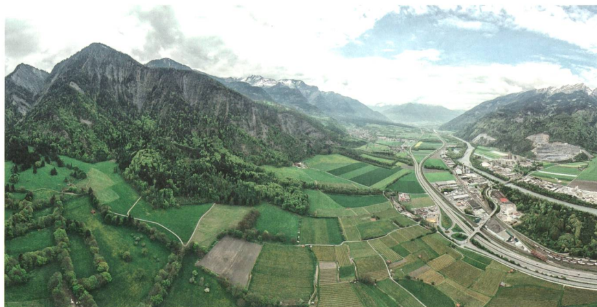
Bild 1 Im Industriegebiet vom Trimmis an der Autobahn A13 ist die Kraftwerkszentrale geplant. Der Druckstollen geht im Gebirge links in die talwärts führende Druckleitung über.
