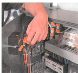
Hochstromtragfähige Metalle ermöglichen Ströme bis 16 A und mehr.
