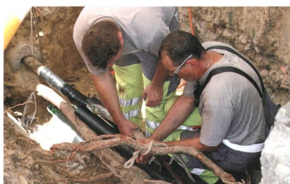
Netzelektriker bei Reparaturarbeiten an einem 13-kV-Stromkabel.
