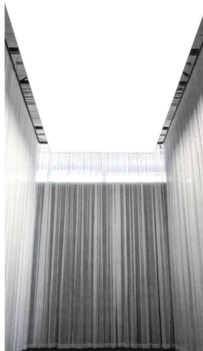
Figure 3 Solutions lumineuses LED intégrées à l'architecture.
