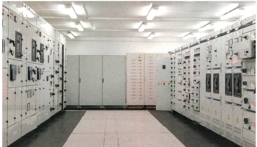
MS-Schaltanlage.
