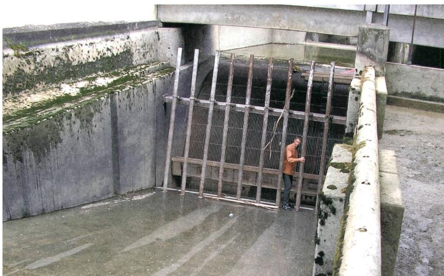
**Bild 5** Wasserkraftanlage am Mühlbach in Landsberg am Lech, Segmentbogen-Rechenreinigungsanlage mit vorgeschaltetem Grobrechen.
