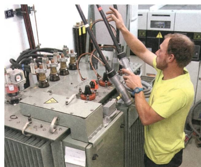
Dank der Montage eines regelbaren Ortsnetztransformators (RONT) musste keine zweite Trafostation gebaut werden. Foto: La Goule
