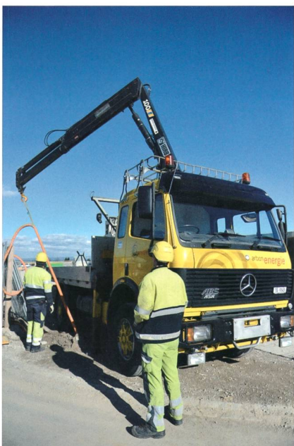
Figure 7 Le fournisseur d'énergie de Thurgovie Arbon Energie AG exploite, outre un réseau électrique, aussi un réseau de fibres optiques.
