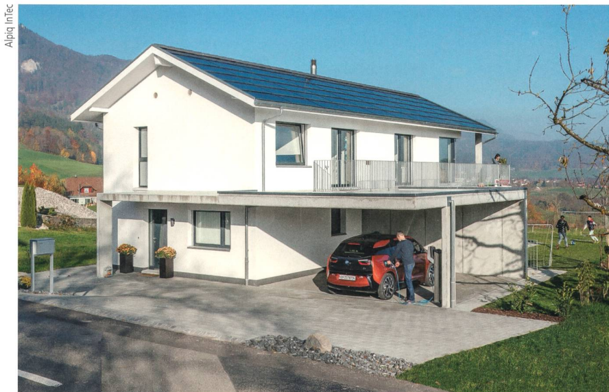
Bild 2 Eines der 40 Einfamilienhäuser im solothurnischen Riedholz, wo in einem Pilotversuch getestet wird, wie sich die Belastung des Verteilnetzes dank «kluger» Steuerung der Verbraucher optimieren lässt.
