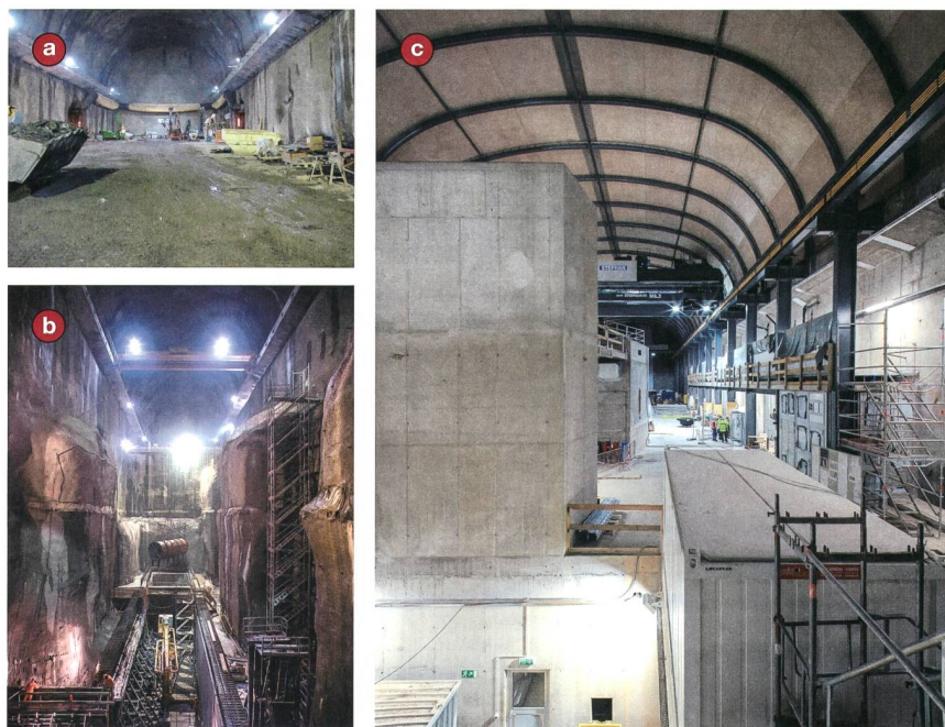
Figure 6 Caverne principale : (a) fin de l'étape 3 pour le début des injections d'étanchéité (11 décembre 2012), (b) fin des excavations (31 janvier 2014) et (c) pendant les mises en service (29 juin 2016).
