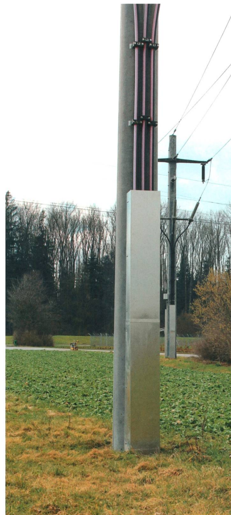
Neues CableMan-Abschirmsystem für Kabelaufstiege für Einhaltung des Immissionsgrenzwertes ( 100 \mu\text{T} ) nach NISV in der Höhe von 0,2 bis 2 m.
