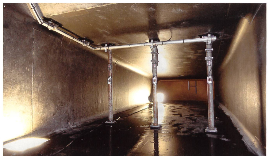
Bild 1 Thermodynamische Niederdruckmessebene mit drei vertikalen Stangen und sechs innenliegenden Temperaturlaufnehmern beim Saugrohraustritt im Hochdruckkraftwerk Filisur, CH.
