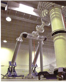
HVDC-Tests der neuen Kabel.
