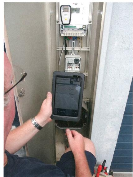
**Bild 4** Parametrierung der Relais.
