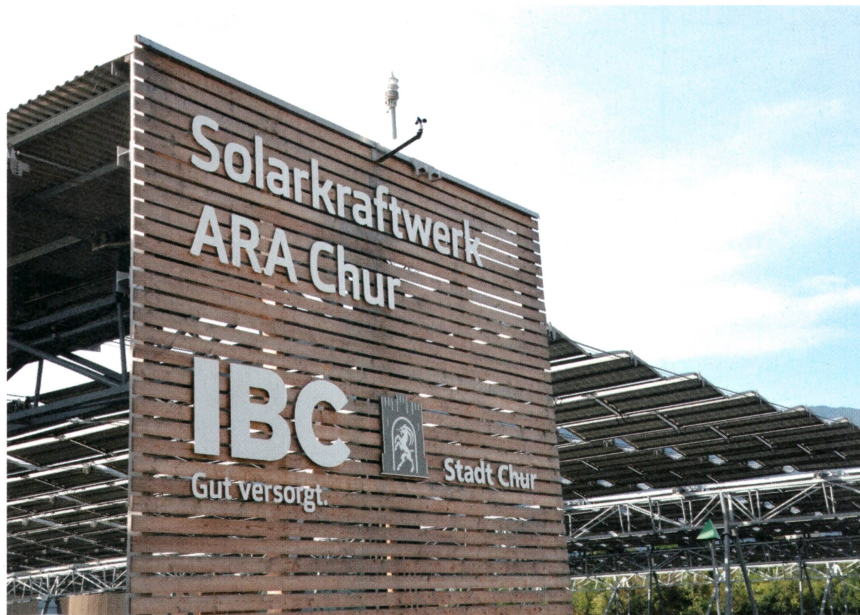
Das PV-Dach deckt rund 20 % des Strombedarfs der ARA Chur ab.
