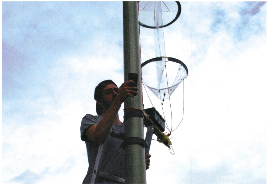
An dieser Strassenleuchte ist neben der Insektenfalle ein «Batlogger» montiert. Dieser zeichnet in der Nacht die Ultraschall-Echoortungslaute von Fledermäusen auf. Die Daten werden am nächsten Morgen per Smartphone heruntergeladen.
