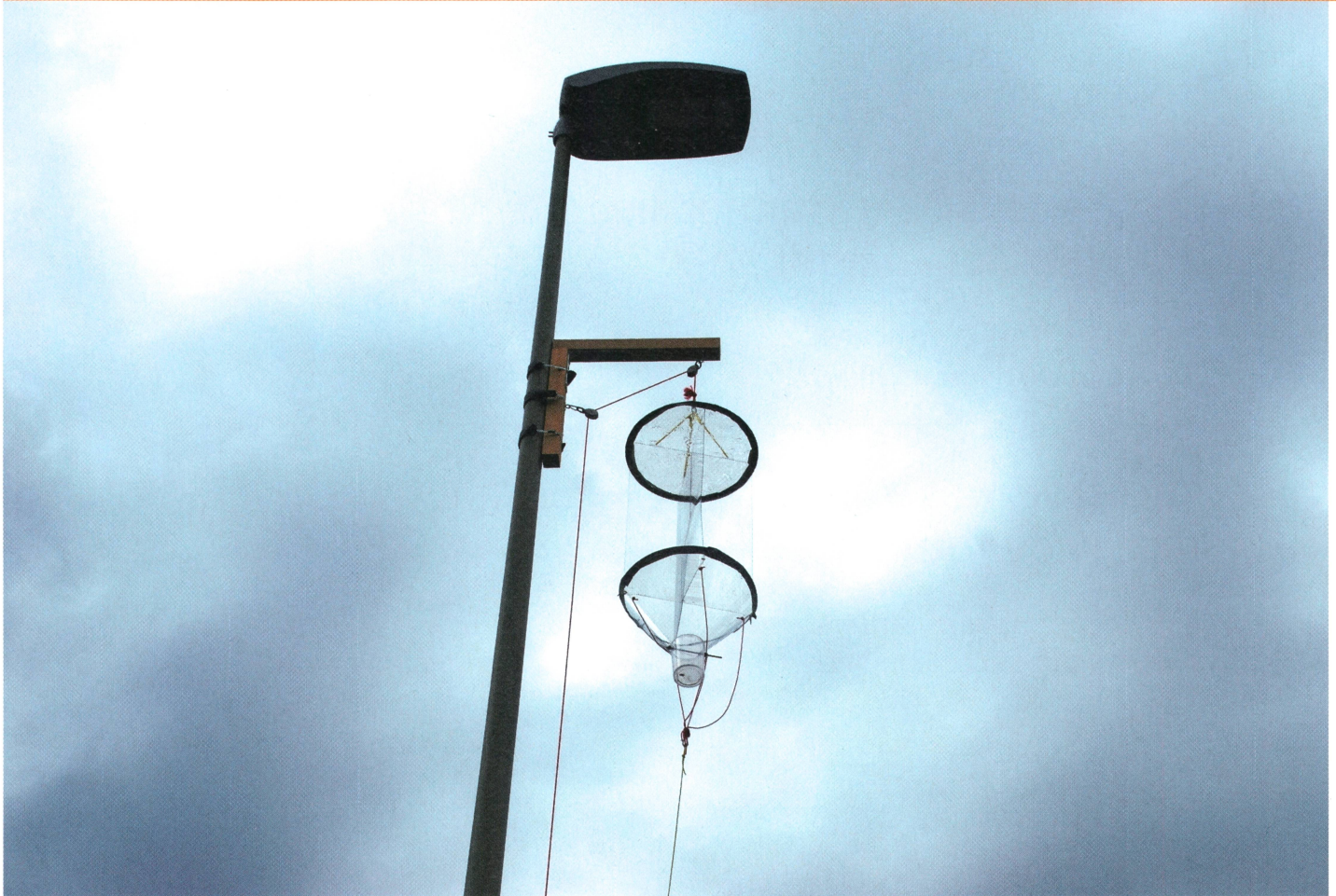
Strassenleuchte mit Insektenfalle in Urdorf am frühen Morgen: Im Auffangbecher befinden sich ein paar Insekten.
