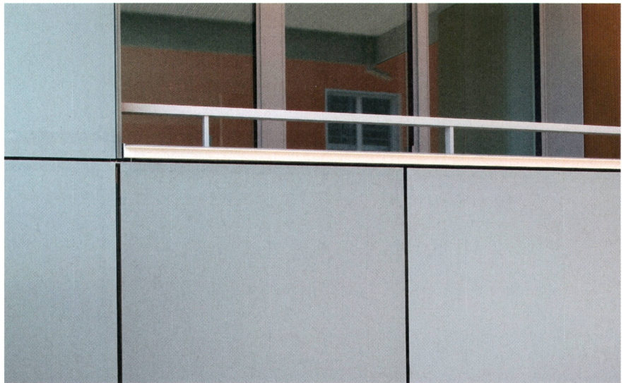
Bild 1 Unsichtbare Photovoltaik in aktiver Glasfassade.
