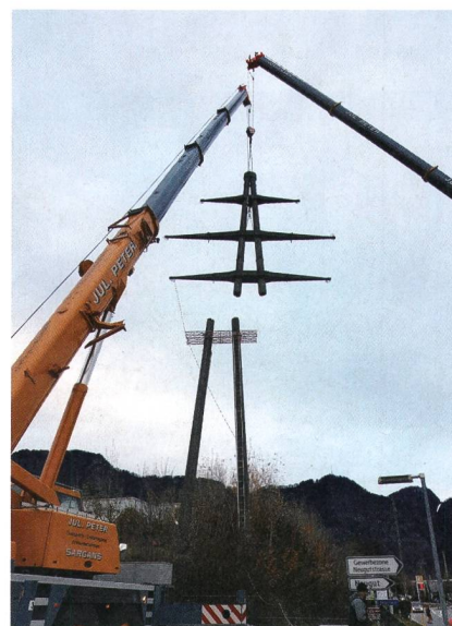
13 Strommasten wurden im Raum Landquart rückgebaut.
