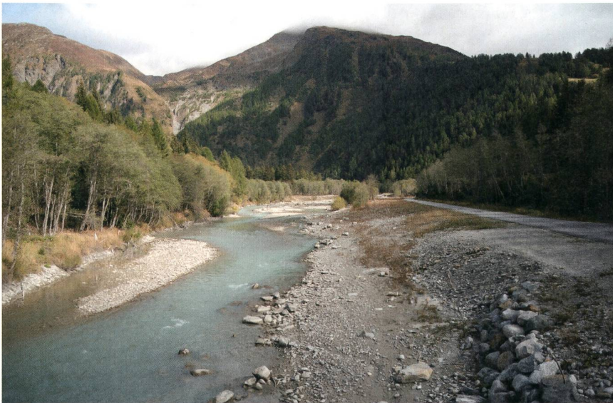
Die mit dem Bau des Wasserkraftwerks renaturierte obere Rhone.
