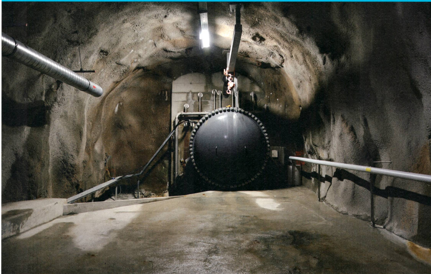
La fin de la nouvelle galerie d'aménée à Oberwald.
