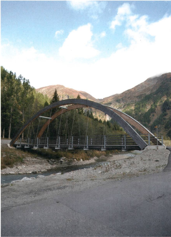
Die neue Brücke für Fussgänger war Bestandteil der Zusatzmassnahmen.
