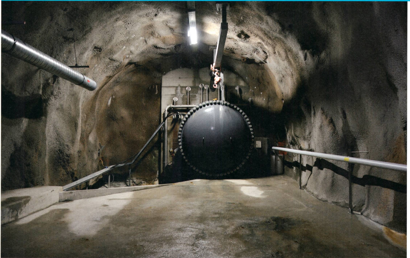
Das Ende des neuen Triebwasserstollens in Oberwald.
