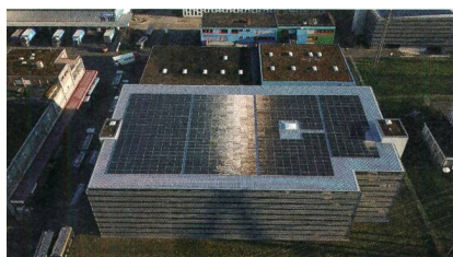
Die Module auf Parkhaus 3.
