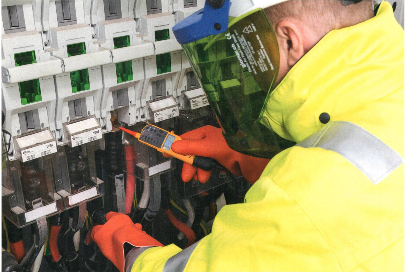
Mesure avec un EPI dans un ensemble d'appareillages sans protection contre les contacts.
