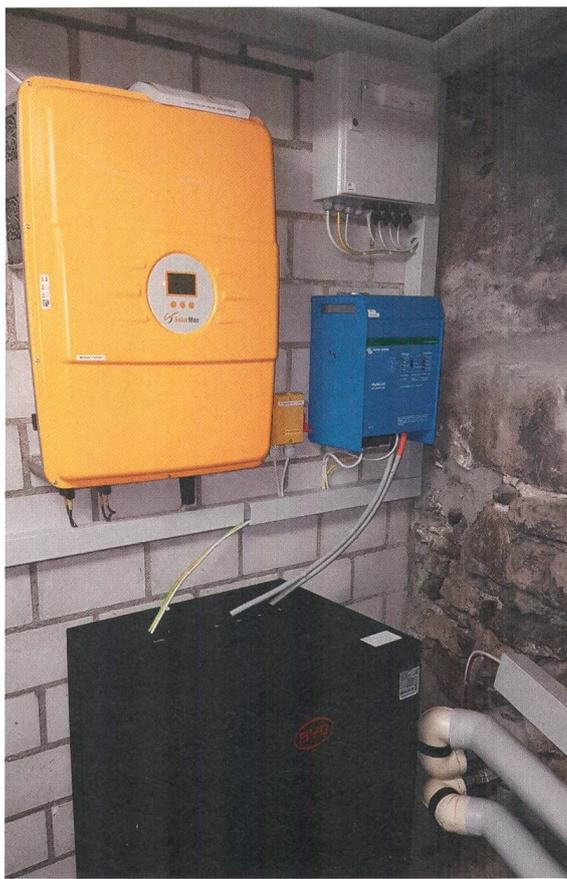
Energiespeicher im Quartierstrom-Netz: Insgesamt sind sieben Speicher mit einer Gesamtkapazität von 80 kW in den lokalen Strommarkt eingebunden.
