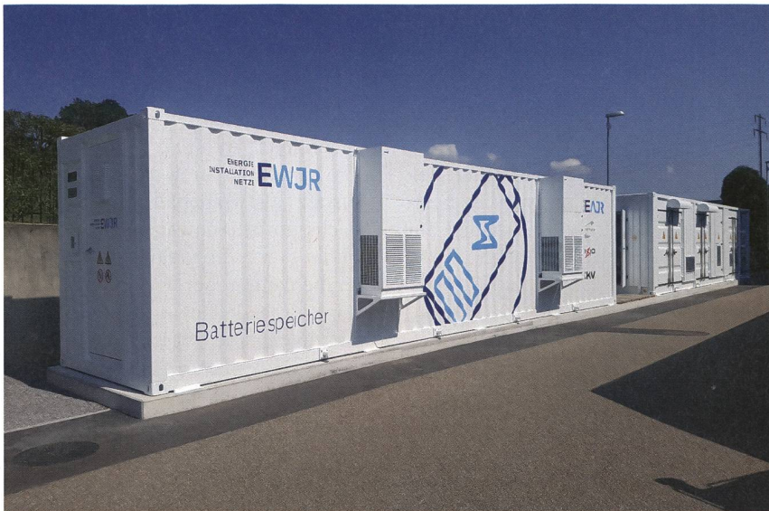
Nach der Installation wurde der Batteriespeicher für die Elektrizitätswerk Jona-Rapperswil AG in Betrieb genommen.
