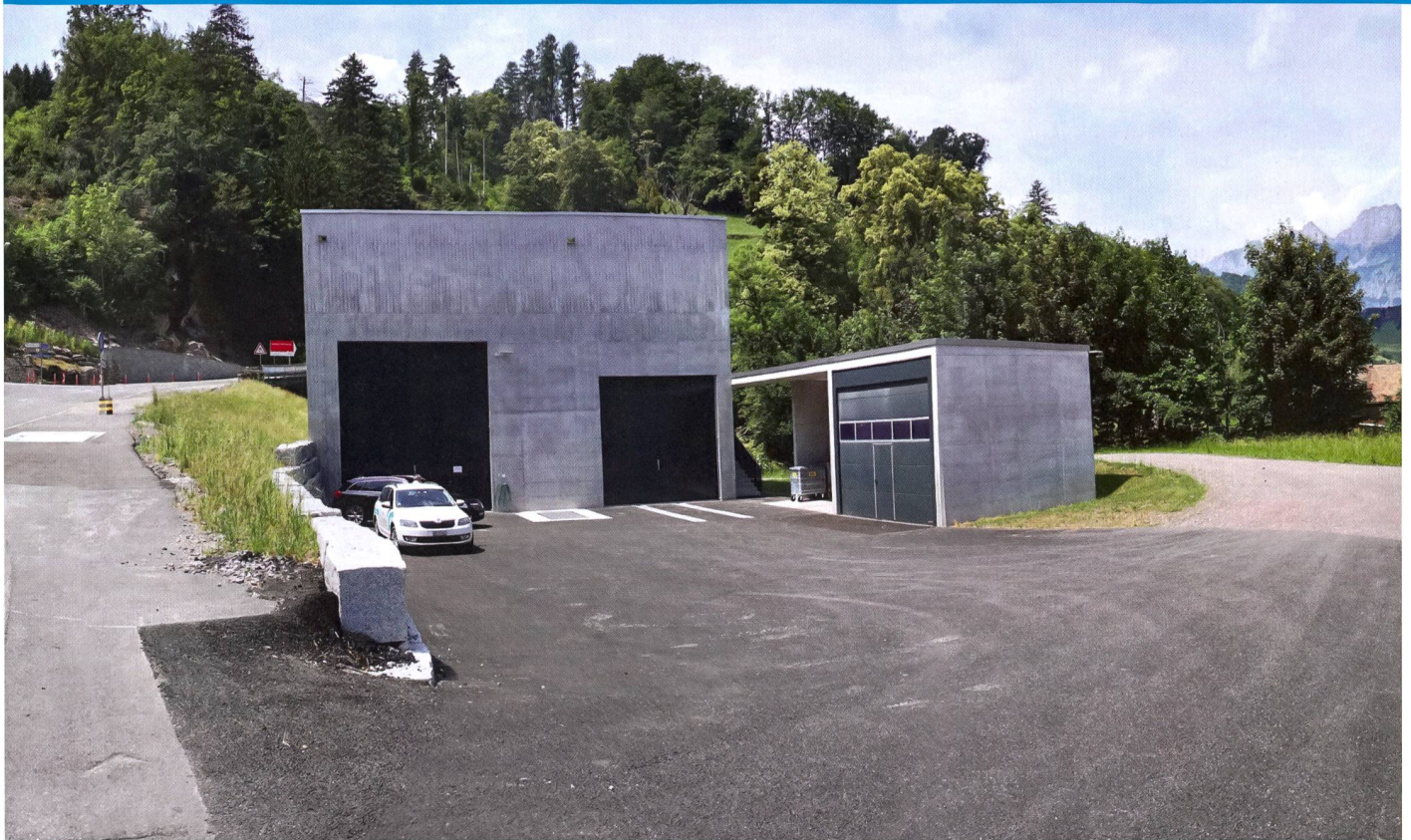
Kraftwerkszentrale Sängüetli in Flums.
