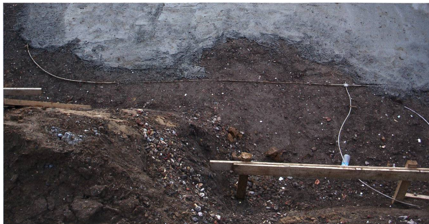
Protection intérieure contre la foudre : électrode de terre de fondation dans l'excavation d'une maison individuelle.
