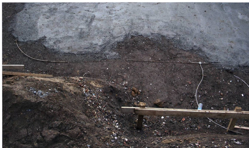
Innere Blitzschutz: Fundamenterder in der Baugrube eines Einfamilienhauses.
