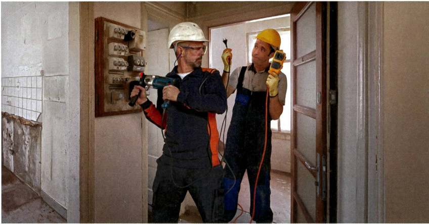
Les ensembles d'appareillage peuvent renfermer de l'amiante.
