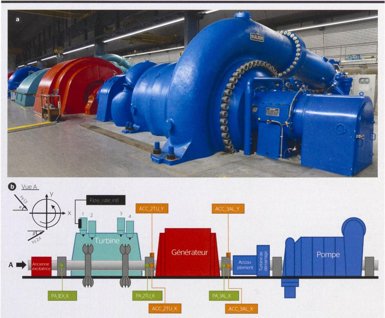
**Figure 2** Étude expérimentale sur un groupe ternaire de la centrale de Veytaux 1 dans le cadre du projet OFEN HydroLeap : a) vue du groupe ternaire étudié, et b) instrumentation du groupe pour la mesure de l’empreinte vibratoire.
