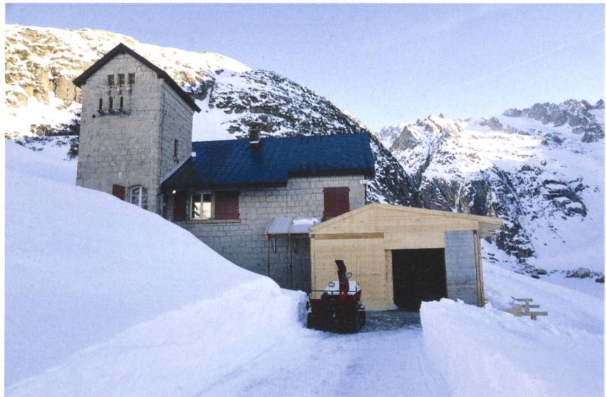
Bild 1 Das Wärterhaus mit der temporären Einhausung.
