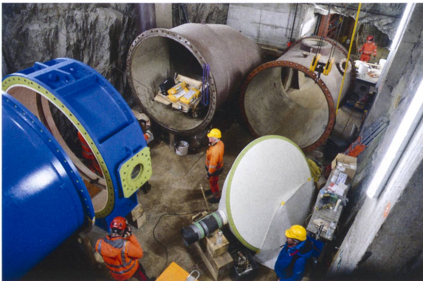
Bild 4 Apparatekammer mit demontierter Drosselklappe und Druckschacht. Der Vermessungswagen im Druckschacht wird mit einer Seilwinde heruntergelassen.
