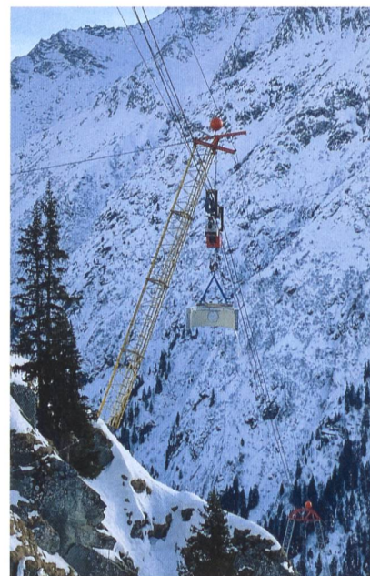
Mit der Bauseilbahn wurden die bis 10 t schweren Einzelteile der Drosselklappe transportiert.
