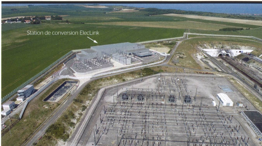
Figure 5 Réelle proximité des emprises ferroviaires de la station de conversion ElecLink et de la station d'alimentation principale du côté français du tunnel sous la Manche.
