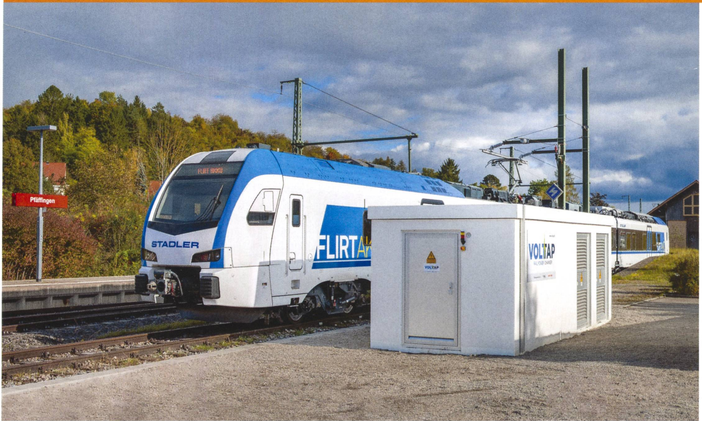
Prototyp der Voltap-Schnellladestation für Batteriezüge.
