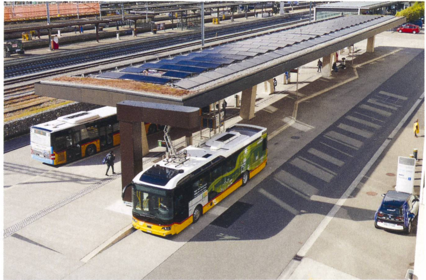
Bild 1 Projekt «Elektropostauto» in Brugg mit der ertragsoptimierten PV-Anlage.
