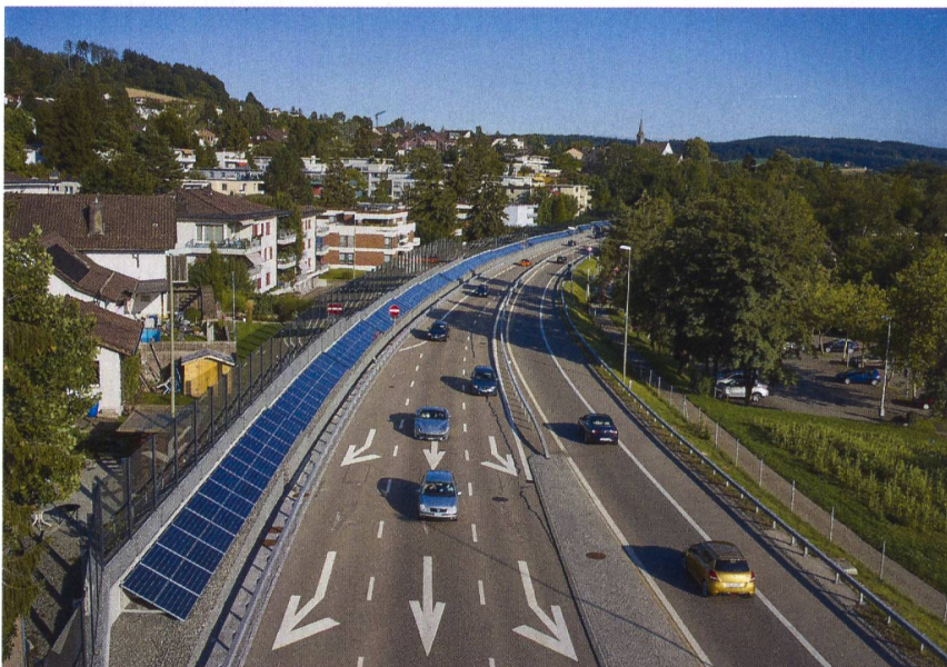
Die PV-Lärmschutzwand in Zumikon entlang der Forchautostrasse wurde bereits 2014 erstellt.
