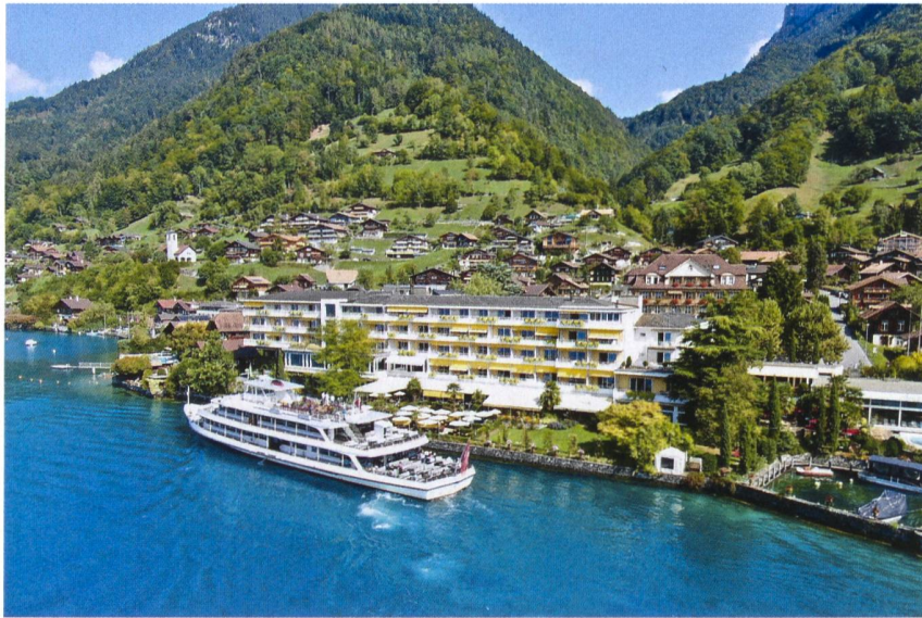
Dank Energiespar-Contracting reduziert sich der jährliche CO 2 -Ausstoss des Hotels «Beatus» um 719 t.
