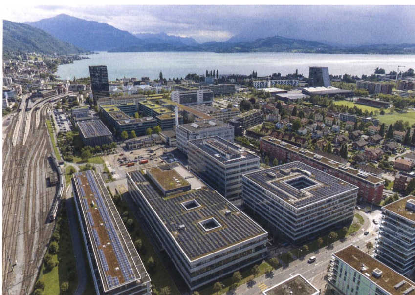
PV-Anlagen auf dem Siemens-Campus in Zug.
