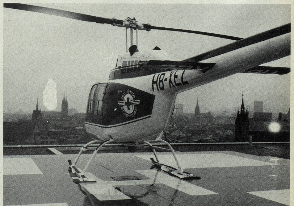
Der in Basel stationierte Rettungshelikopter thront auf dem neuen Dach-Helikopterlandeplatz des Basler Kantonsspitals
