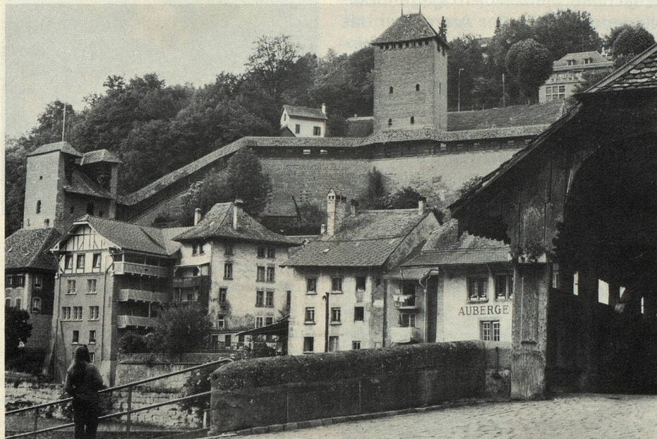
Der älteste Übergang über die Saane: Bern-Brücke mit alter Stadtbefestigung und Rotem Turm
