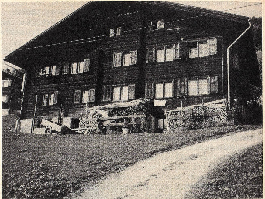
Das Schulhaus mit den zu renovierenden Wohnungen
