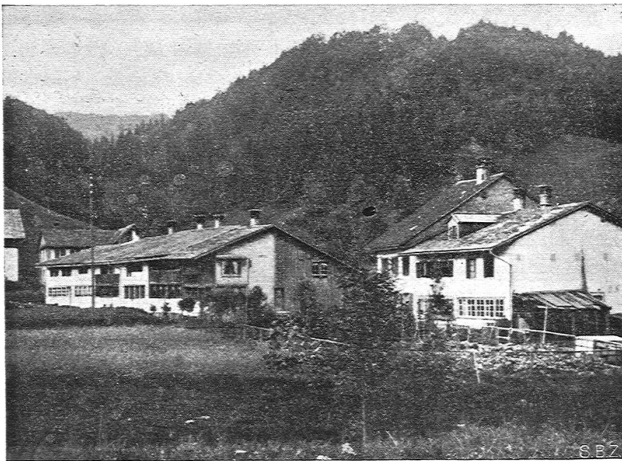
Abb. 11. Reihenhäuser, «Flärz», in Gibswil (Bez. Hinwil) Im «Flarz» rechts ist das hintere Haus umgebaut mit steilerem Dach.
