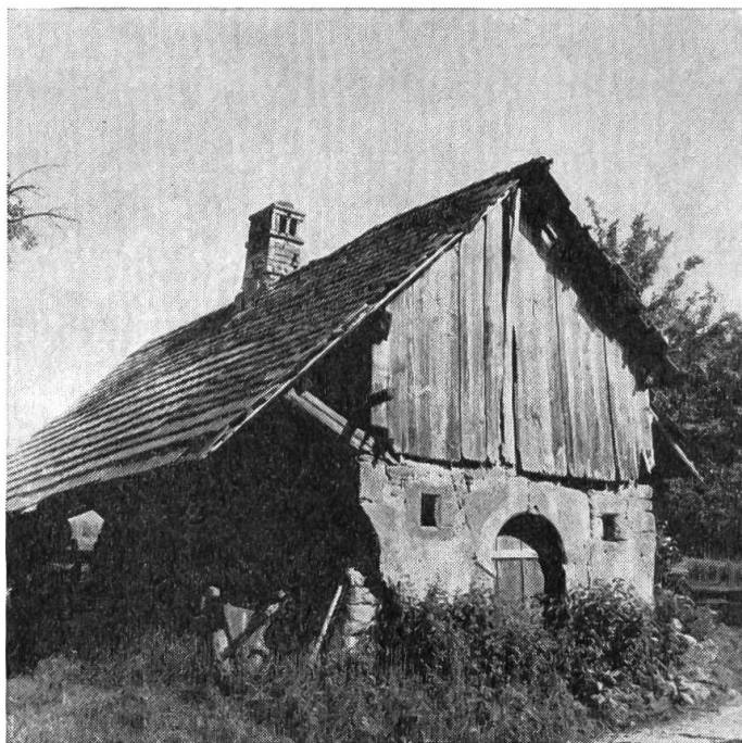
Abb. 1. Privat-Ofenhaus in Lanthen (Kat. Nr. 2). Wahrscheinlich 18. Jahrhundert. Mischbau, mit typisch bernischem Steinunterbau, längsverschlossenem Holzgiebel und Satteldach.
