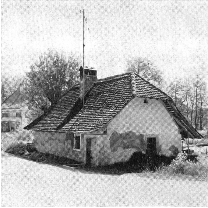
Abb. 3. Gemeinde-Ofenhaus in Ulmiz (Kat. Nr. 111). Reiner Steinbautyp mit Krüppelwalm-dach.
