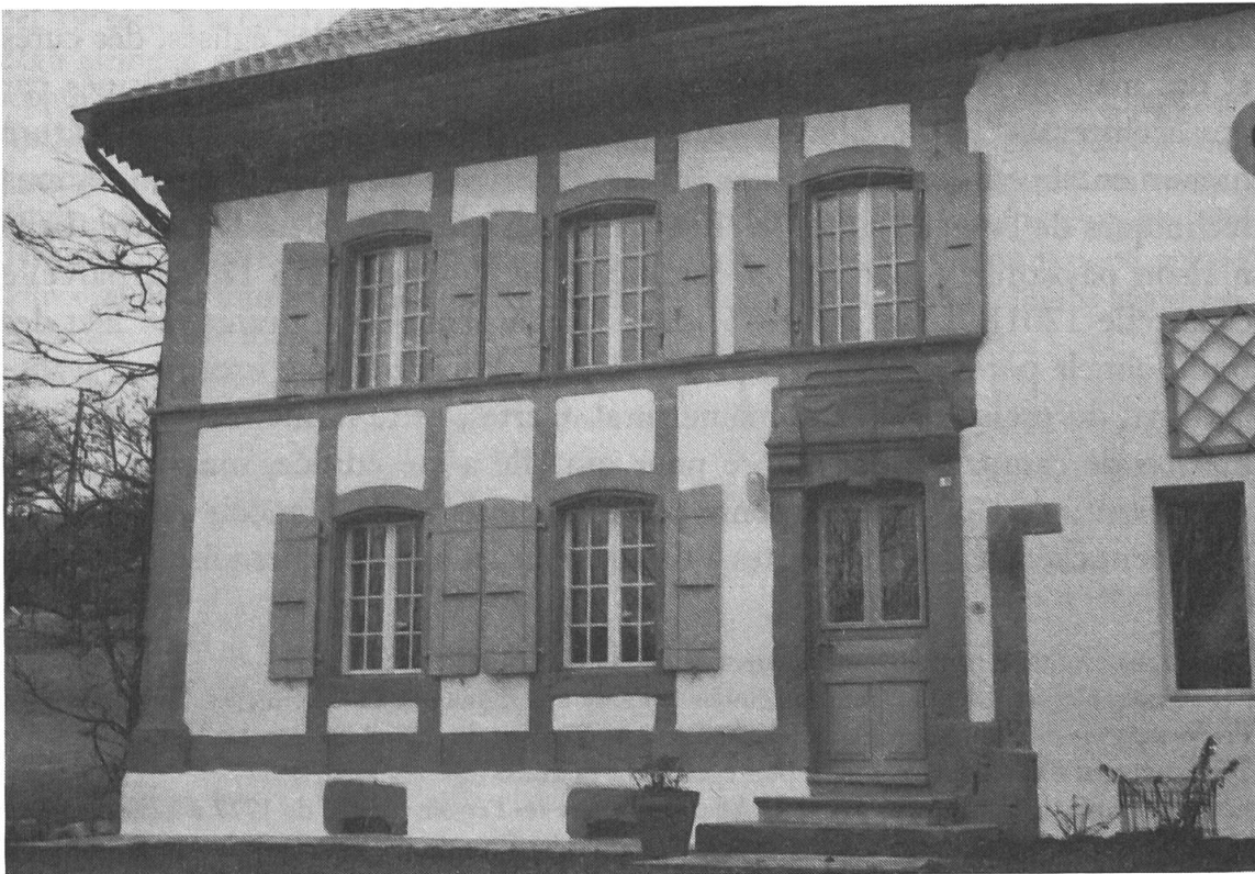
Fig. 12 Orzens (cad. 59), maison paysanne de 1809; traitement particulièrement soigné du logement, structuré par des chaînes d'angle et intermédiaire, un cordon, une corniche soulignée d'une frise de denticules et un dessus de porte richement décoré. A noter l'importance du soubassement, dont la partie inférieure a malheureusement été recouverte d'un crépi blanc lors de la dernière restauration, ce qui lui enlève son apparence de solidité. Ce logement présente encore deux éléments exceptionnels: les piédroits de la porte d'entrée ont la forme de pilastres cannelés (seul celui de gauche est encore visible) et les montants des baies sont systématiquement prolongés, créant un effet de quadrillage de la façade.
