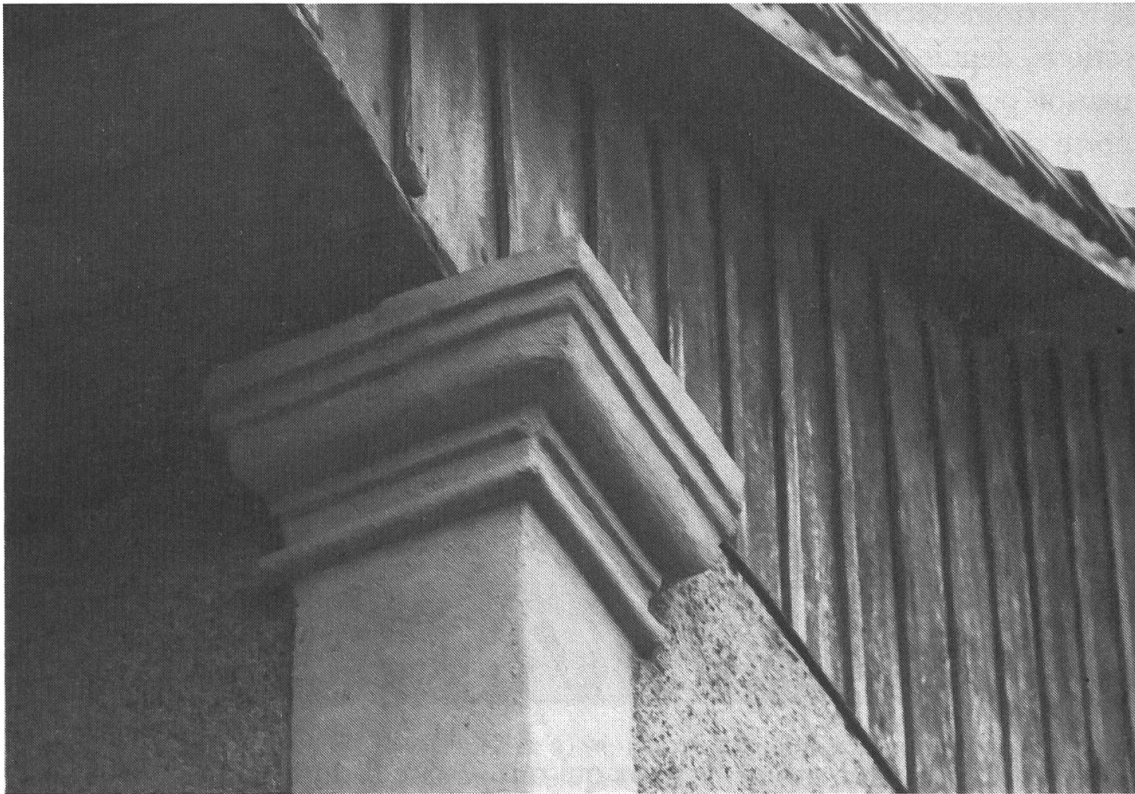
Fig. 9 Hameau d'Épautheyres, commune d'Essertines-sur-Yverdon (cad. 106); chapiteau de 1828 que l'on peut rapprocher de l'ordre toscan (astragale, gorgerin nu, filet, échine et tailloir).
