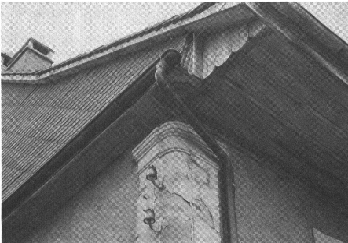
Fig. 10 Orzens (cad. 59, cf. figure 3), chaîne d'angle et chapiteau de 1791, dont l'arête est adoucie par un tracé curviligne (en quart-de-rond), d'une grande habileté d'exécution.
