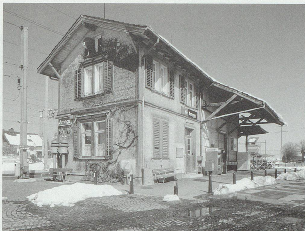
Der Bahnhof Arnegg – ein Stück Eisenbahngeschichte zu Beginn des 21. Jahrhunderts. (Bild kant. Denkmalpflege)
