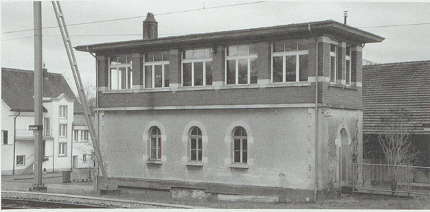
Das Stellwerk Uznach wartet auf eine neue Aufgabe. (Bild kant. Denkmalpflege)
