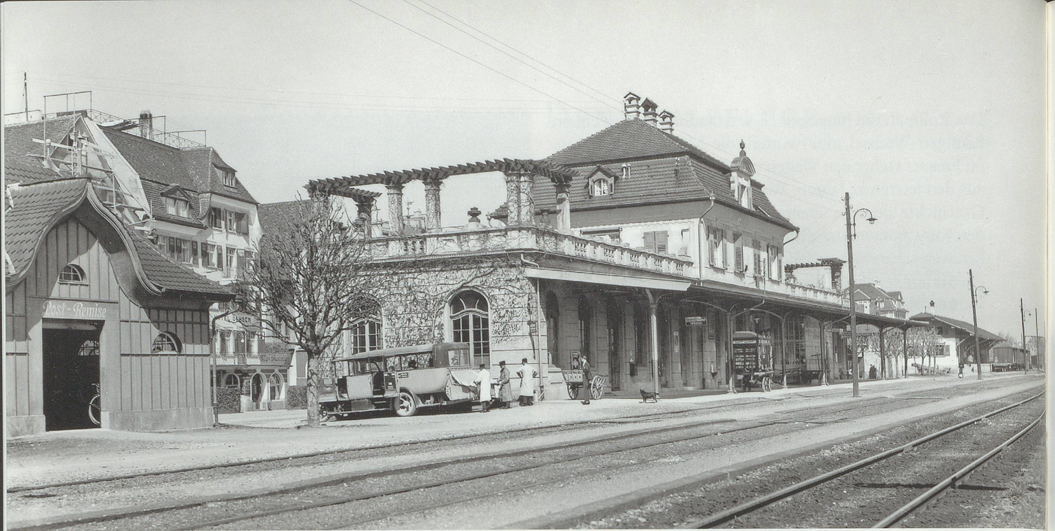
Der Bahnhof Rheineck mit Postremise und Postauto um 1930. (Bild Eidg. Archiv für Denkmalpflege)
