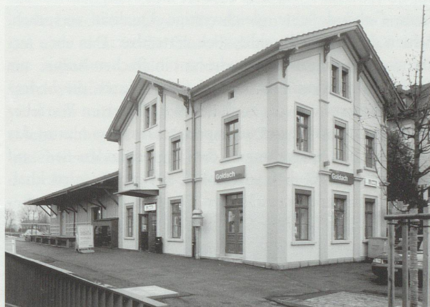
Der renovierte Bahnhof Goldach. (Bild kant. Denkmalpflege)
