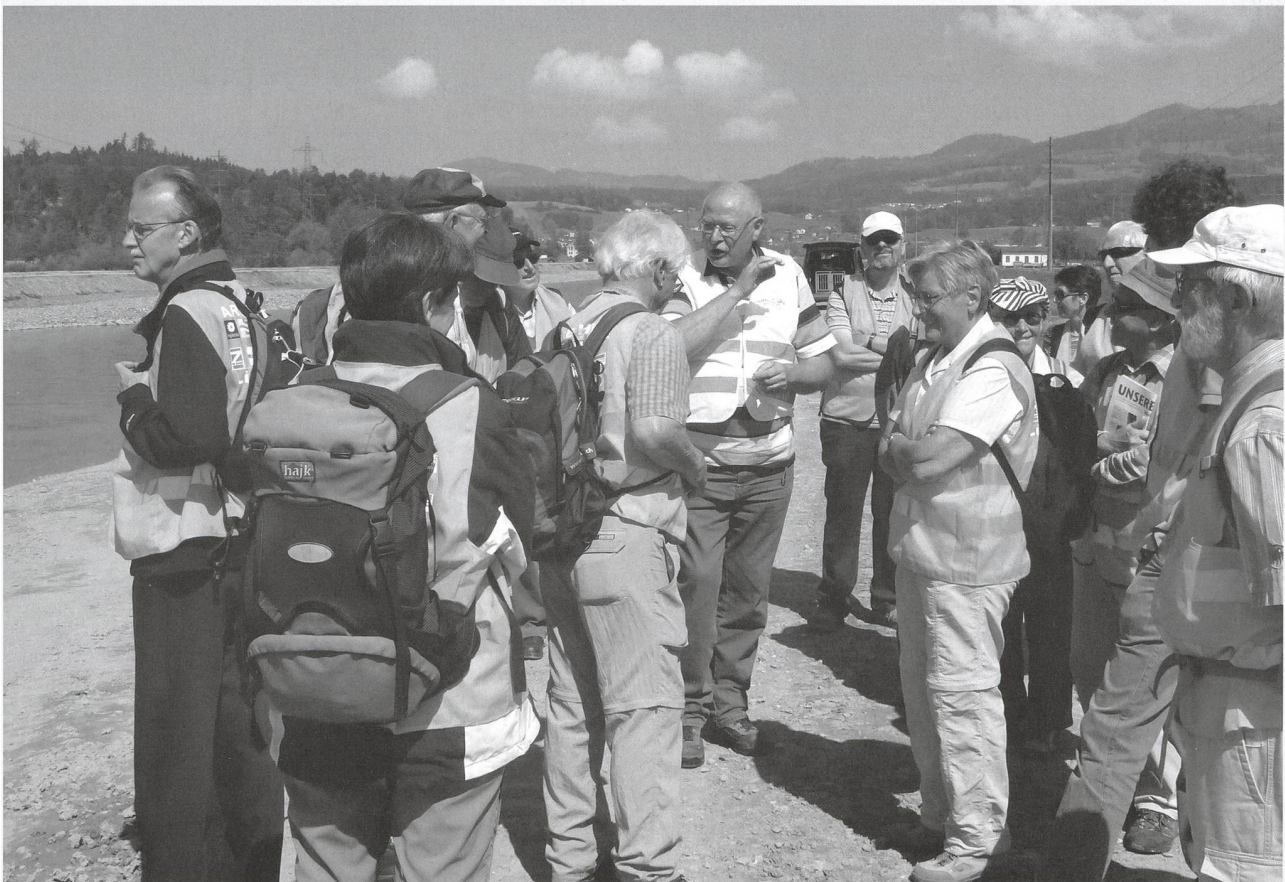
Linthwerk, 30. April 2011. Heiner Keller in der Mitte erläutert den Aufbau des neuen Linthkanal-Hauptdamms. Bild: Ernst Grob.
