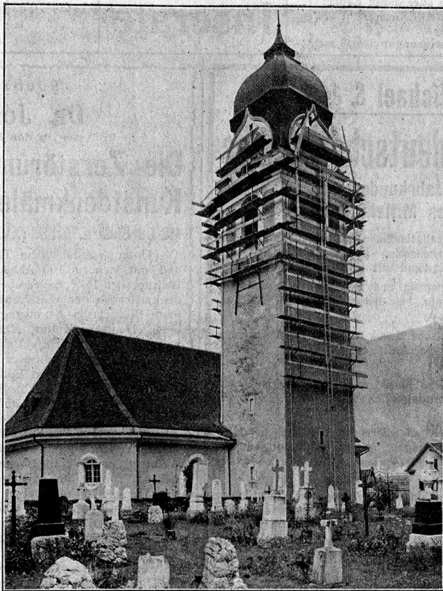
Turm-Gerüst, System „Blitz“ (für Uhr und Verputz-Reparaturen)
