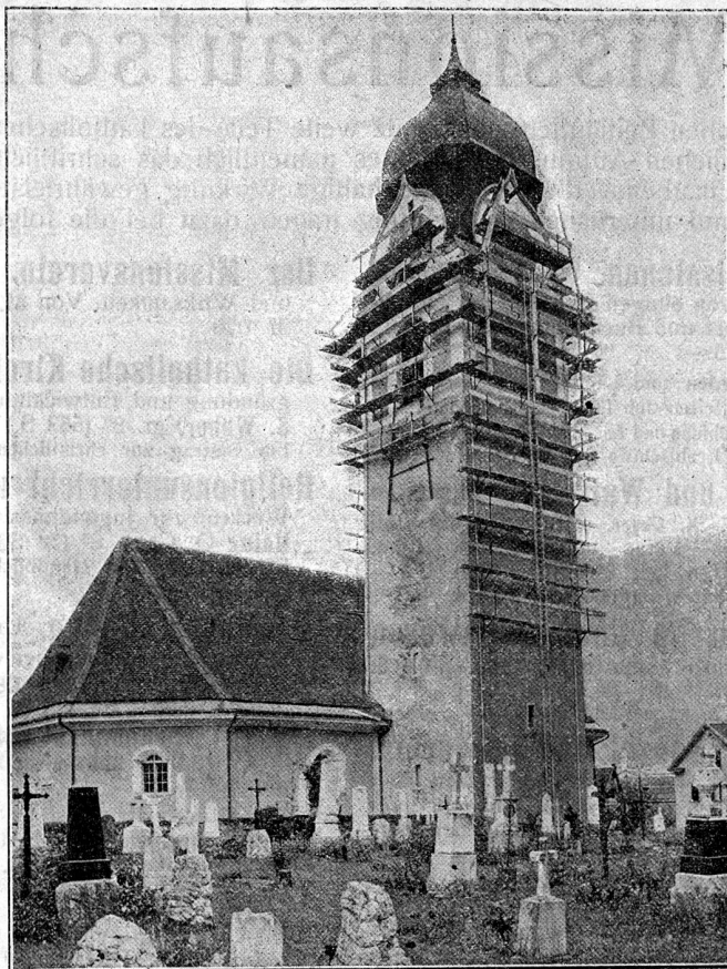
Turm-Gerüst, System „Blitz“ (für Uhr und Verputz-Reparaturen)
