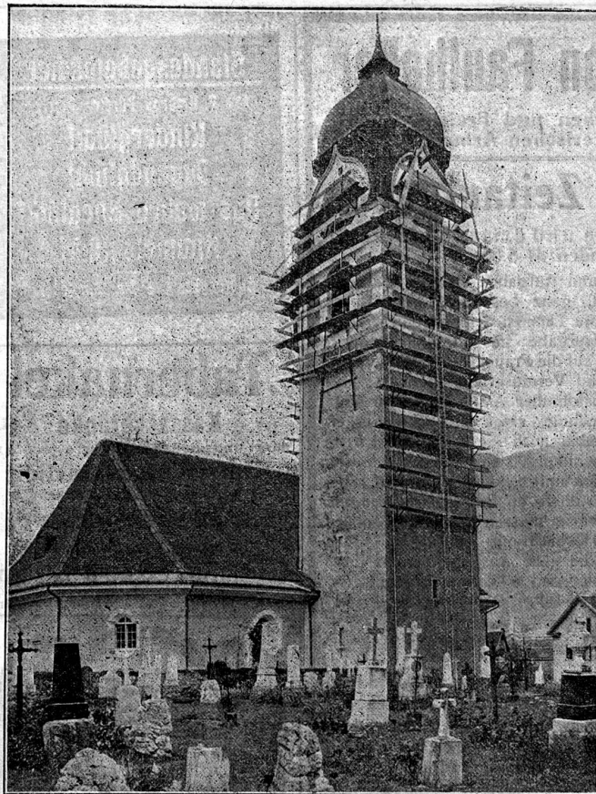
Turm-Gerüst, System „Blitz“ (für Uhr und Verputz-Reparaturen)
