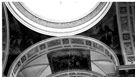
Nach den Arbeiten: Alles leuchtet hell.
